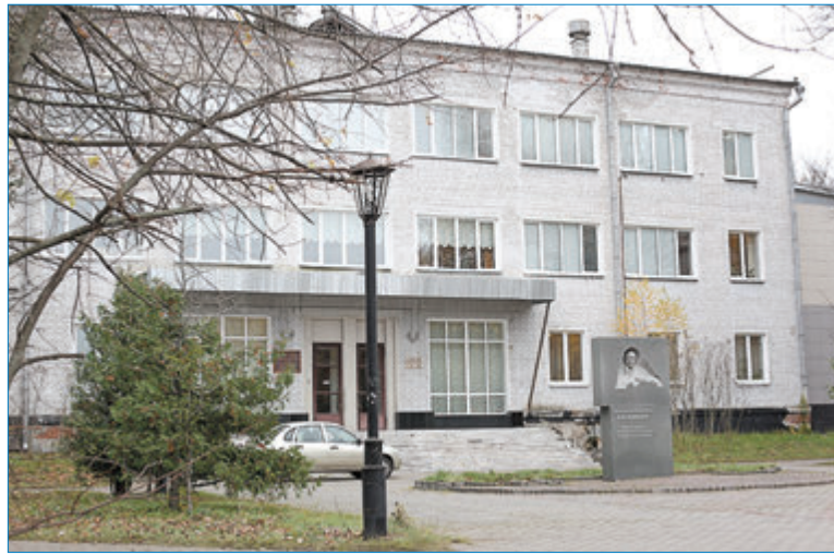
Здание филиала НИИЯФ МГУ
